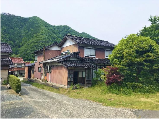
外観（南西から）
